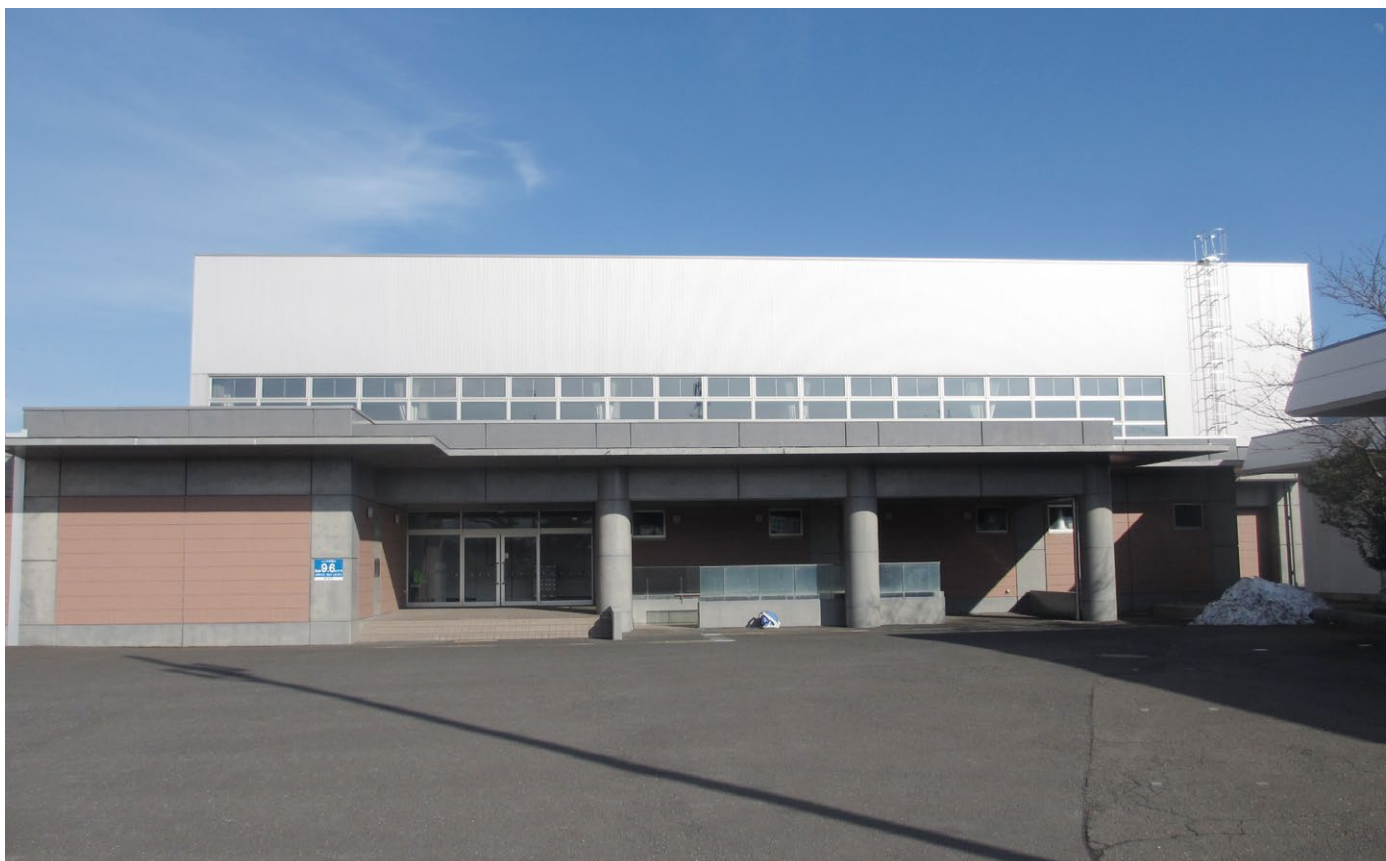
体育館外観 (改修前)
