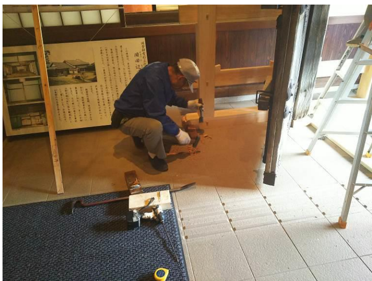
⑳扉止め設置
