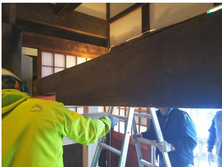
⑨冠木据え付け
