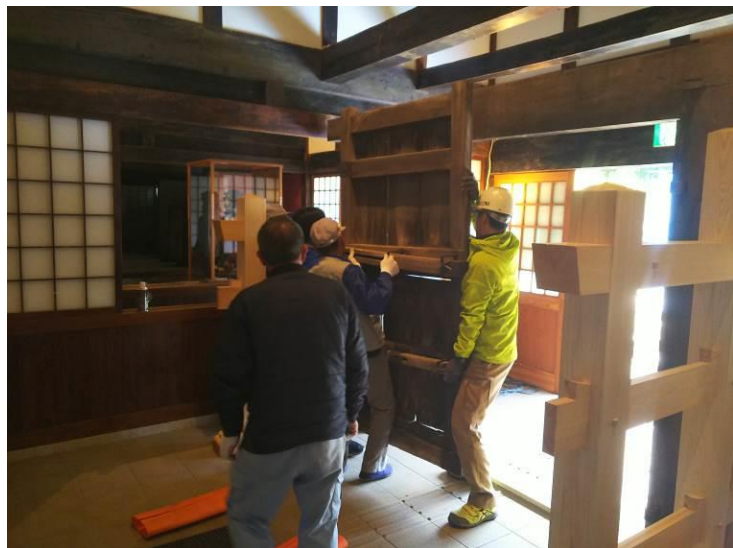
⑭右扉据え付け
