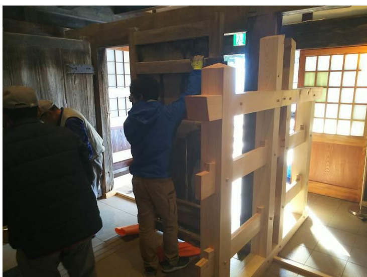
⑰左扉据え付け
