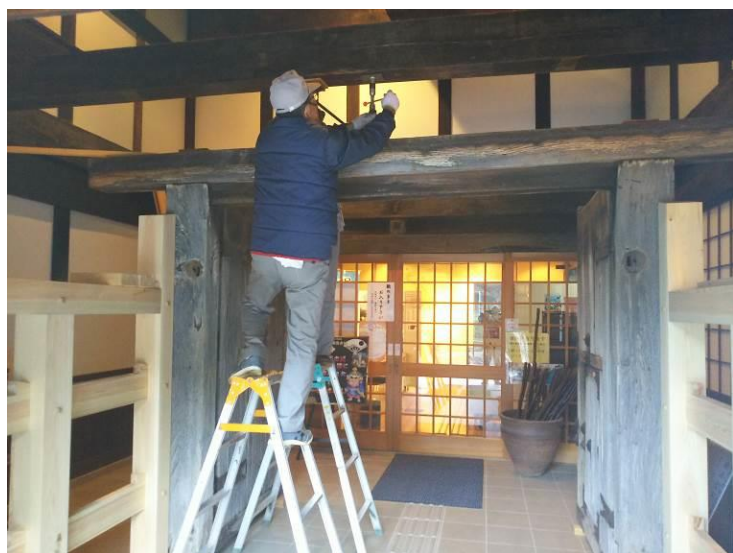
㉑冠木支柱設置
