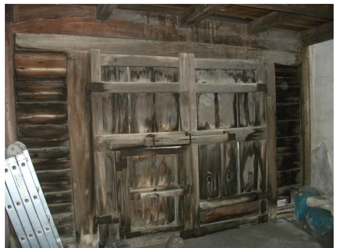
解体前の同門扉部裏
