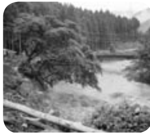
● 豪雨災害復旧 (平成17年8月13日発生)
