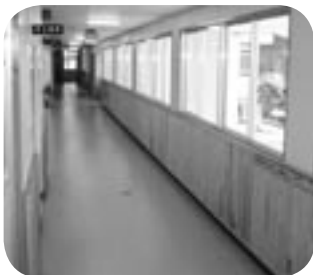
● 美浜東小学校改修工事
