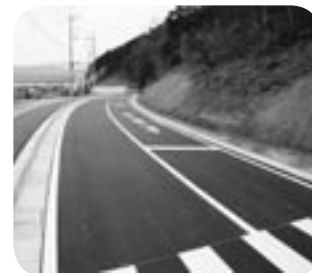
● 町道佐柿・郷市線 道路改良工事
