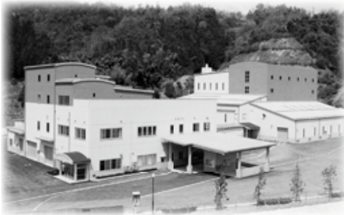
エコクル美方（右奥がガス化溶融施設）
