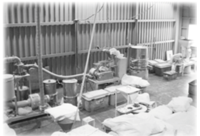
(株)エアグリーン 和歌山工場
