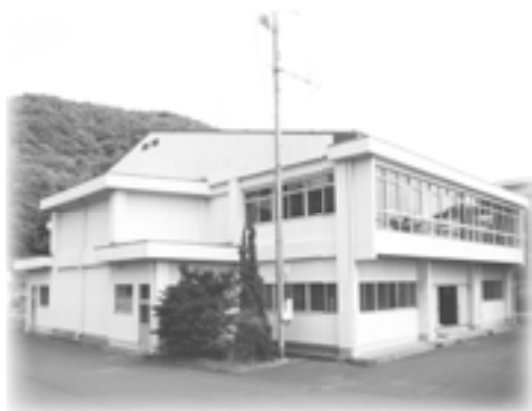
補強工事を行う丹生小学校体育館
