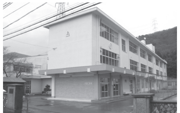
↑今年3月に補強工事が終わった丹生小学校校舎
