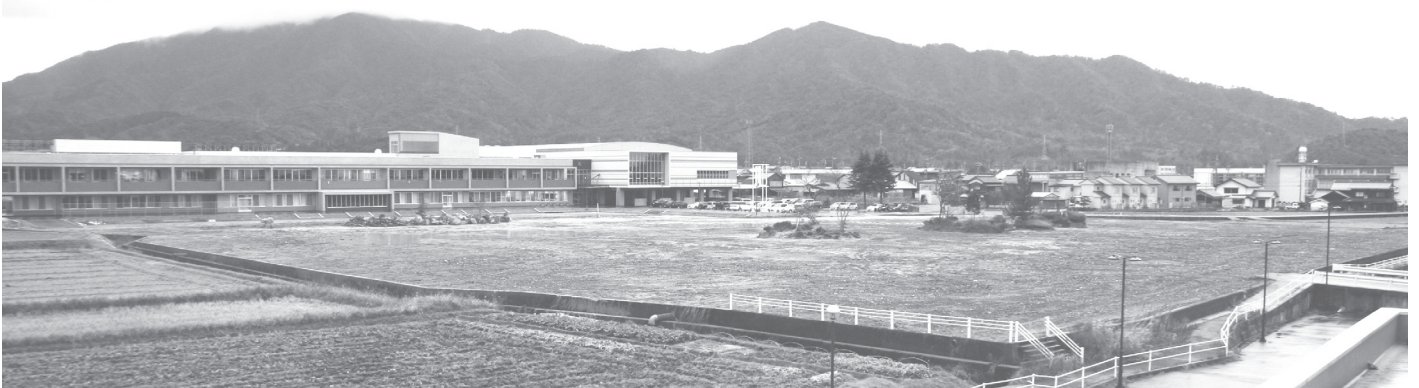
↑美浜中学校のグラウンドと外構は、平成22年8月の完成を予定しています。
