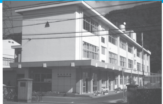
↑耐震補強と改修工事を行う丹生小学校校舎
