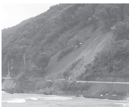
↑ 県道佐田竹波敦賀線で発生した土砂崩れ
