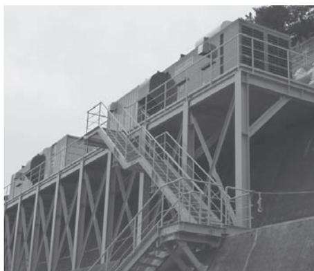
↑9月に美浜発電所に配備された非常用発電機代替設備(空冷式非常用発電機)
