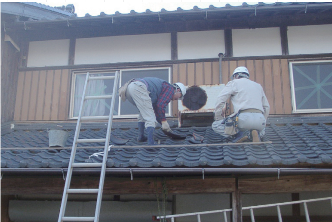
↓ 破損した屋根瓦を取り替える組合員
