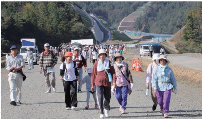
↓建設工事中の舞鶴若狭自動車道を歩く参加者
