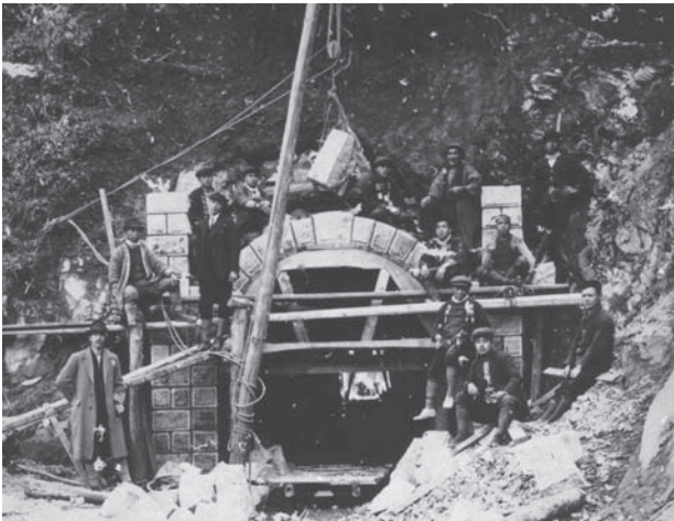
↑完成間近の隧道（大正14年）『写されたわかさ美浜』より
