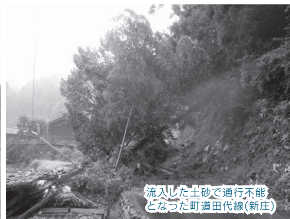
耳川護岸の崩落(佐野)
