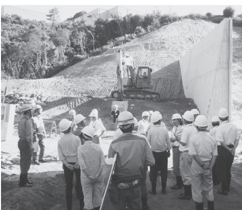
↑工事が進む防潮堤(あご越え)を視察する委員
