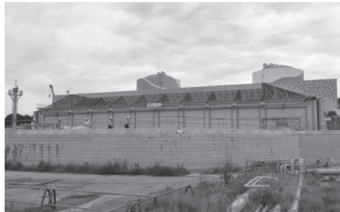
↑津波による浸水を防ぐため、海水ポンプを囲む防護壁と防護堤
