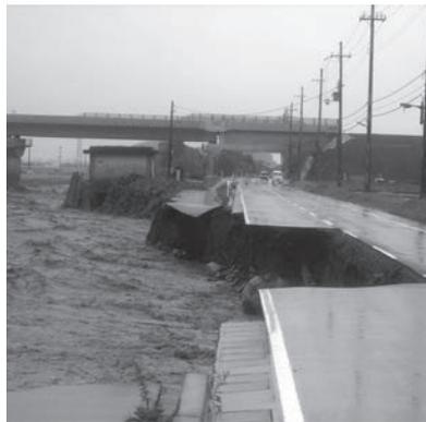
↑大雨の影響で耳川が氾濫し、県道松屋河原市線の一部が崩落(宮代～佐野)
