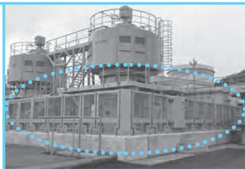
↑ 昨年10月31日に完成した1・2号機取水設備周りの防護壁(海拔6m/延長約70m)
