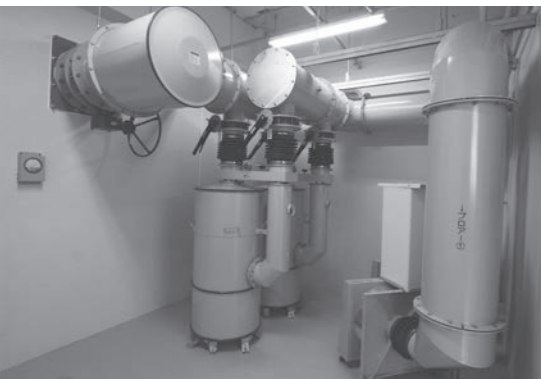
↑放射線防護区域を陽圧に保つとともに、汚染された外気を除去する「フィルトリングシステム」
