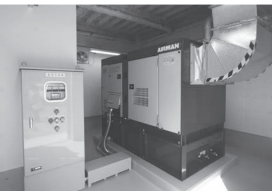
↑停電時に、放射線防護区域に電力を供給する「非常発電機」
