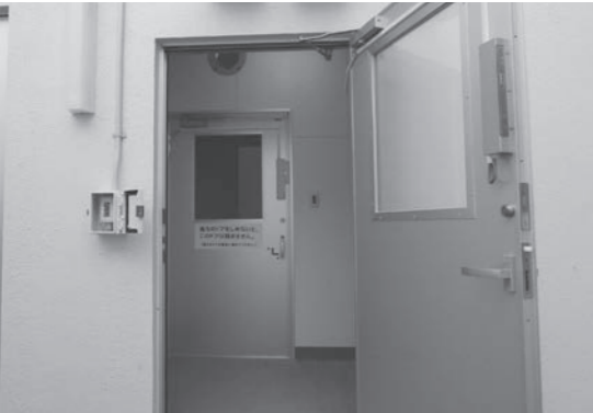
↑汚染された外気の侵入を防ぎつつ、人の出入りを可能とする「エアロック室」
