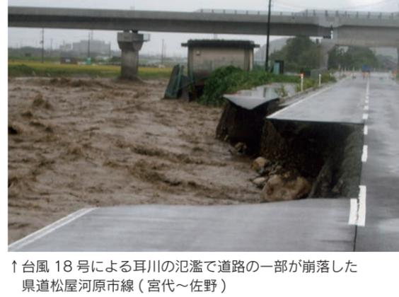
↑台風18号による耳川の氾濫で道路の一部が崩落した県道松屋河原市線(宮代~佐野)
