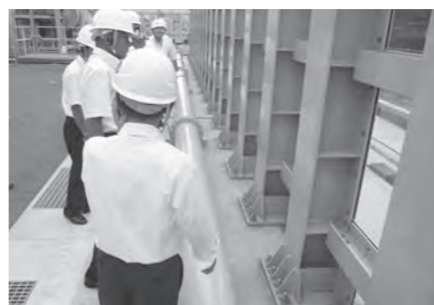
↑美浜3号機の海水ポンプ周りの防護壁を確認する委員
