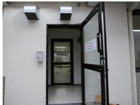
↑ 汚染された外気の侵入を防ぎつつ、人の出入りを可能とする「エアロック室」
