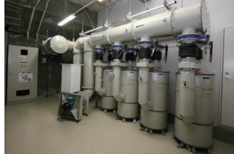
↑ 放射線防護区域を陽圧に保つとともに、汚染された外気を除去する「フィルタリングシステム」
