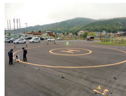
↑丹生に完成した緊急避難用ヘリポート
