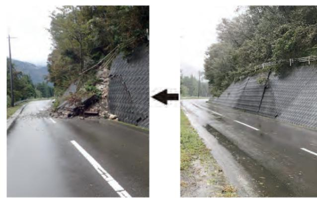
↑のり面が崩落した町道金安線(亀裂の確認から6時間後に崩落)
