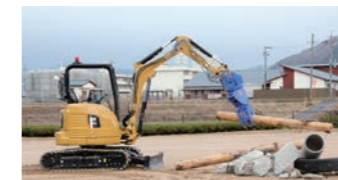
↑無線で操作し、がれきを撤去する重機
