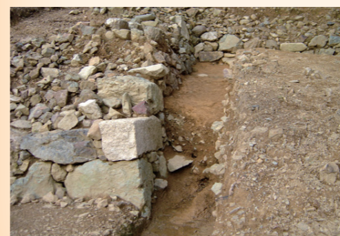
↑II類石垣(奥)とIII類石垣(手前)が共存する 城主居館跡南面石垣
