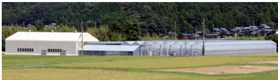
↑施設外観。育苗準備室(写真左)と鉄骨温室(写真右)
