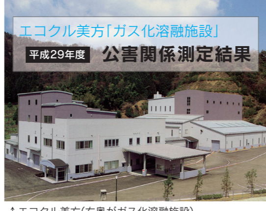
↑エコクル美方(右奥がガス化溶融施設)
