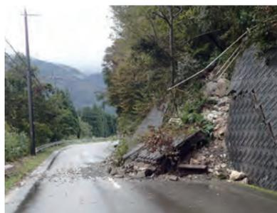
↑昨年の台風でのり面が崩壊した町道金安線
