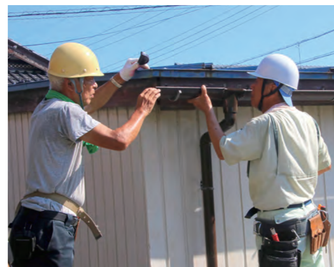
↓雨どいを修理する組員
