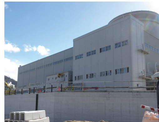
↑ 3号機内海側の防潮堤
