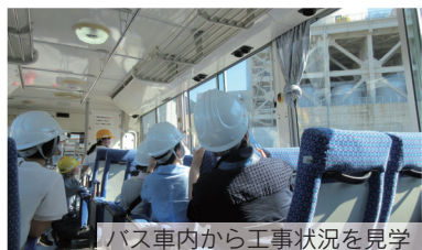
バス車内から工事状況を見学
