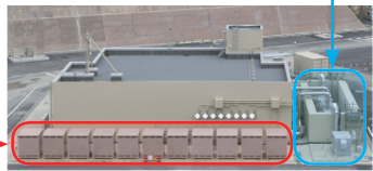
↑ 緊急時対策所(重大事故発生時に必要な指示を行うための施設)
