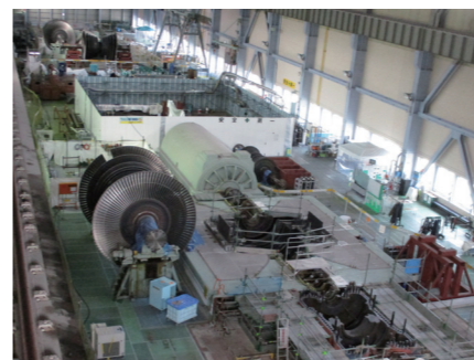
↑1・2号機の廃止措置工事の様子
