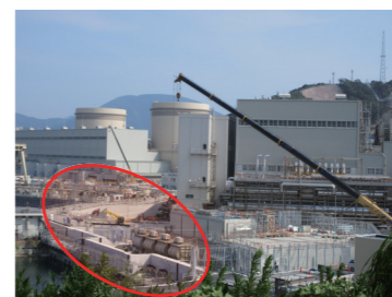
↑3号機を囲うように構築された防潮堤
