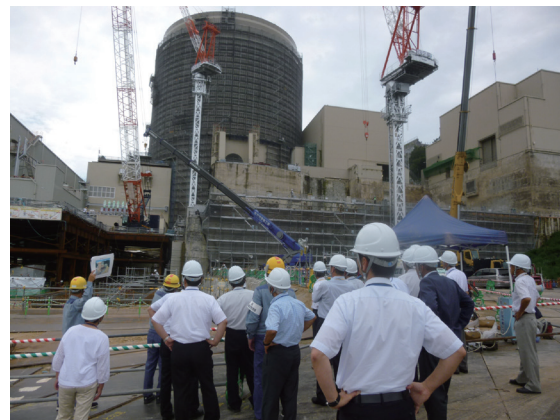
↑ 3号機の安全性向上対策工事について説明を受ける委員
