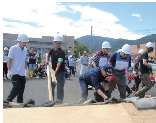
↓ 倒壊した家屋から負傷者を救出するため作業する参加者
