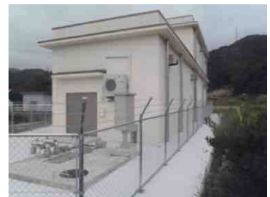
H26 丹生竹波 浄水場更新
