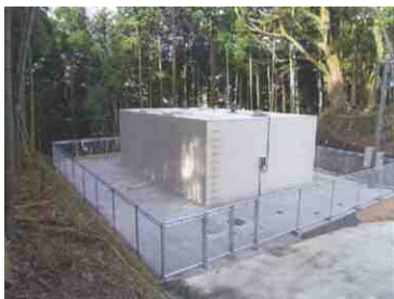
H21 新庄 配水池更新
