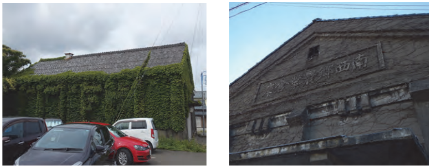
図 2-18 JA倉庫の外観（左）と前面の館銘板（右）
