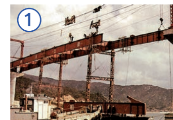
↑ 丹生大橋 橋りょう工事
