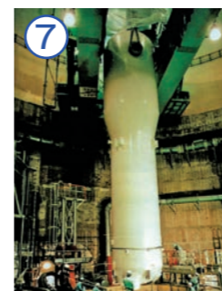
↑ 2号機の旧蒸気発生器を搬出
