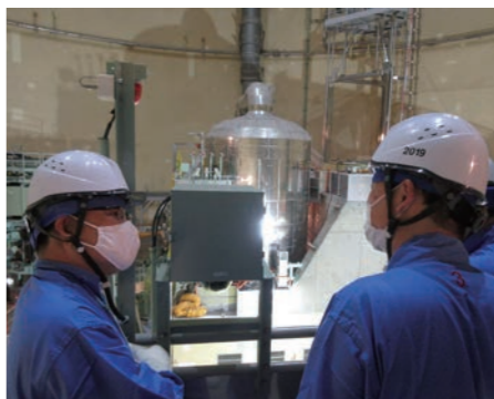
↑原子炉格納容器内の安全対策設備を確認
