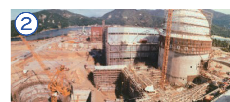
↑ 1・2号機建設工事
