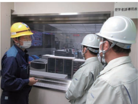
↑デジタル式に更新された中央制御室を確認
