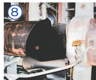
↑ 3号機2次系配管破損事故
