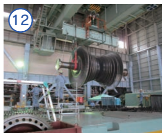
↑ 1・2号機廃止措置工事
