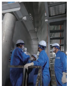
↑補強された原子炉格納容器を確認
