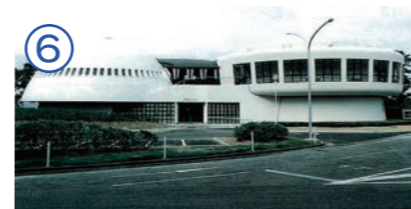
↑ PRセンター改装工事完了
