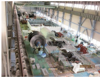
↑ 1・2号機廃止措置工事
