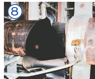
↑ 3号機2次系配管破損事故
