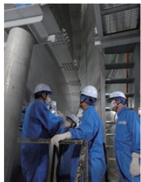
↑補強された原子炉格納容器を確認
