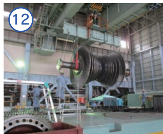
↑ 1・2号機廃止措置工事
