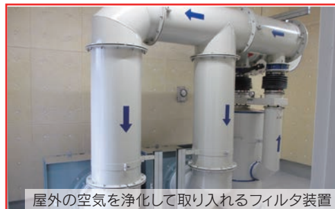
屋外の空気を浄化して取り入れるフィルタ装置
