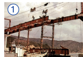
↑ 丹生大橋 橋りょう工事
