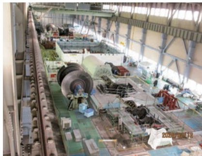
↑ 1・2号機廃止措置工事
