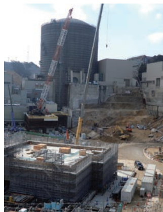
↑ 3号機安全性向上対策工事
