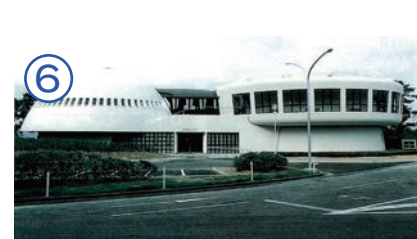
↑ PRセンター改装工事完了
