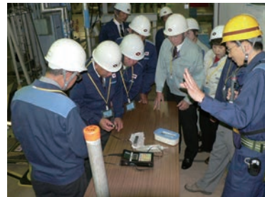
↑ 3号機事故に伴う配管取替状況を確認(平成17年11月)
