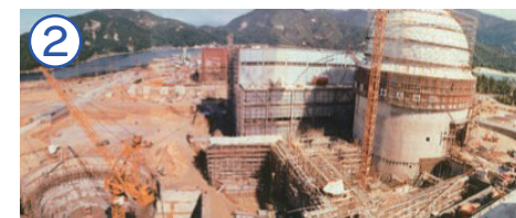
↑ 1・2号機建設工事
