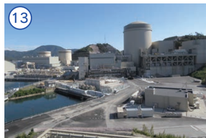
↑ 3号機安全性向上対策工事
