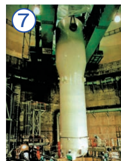
↑ 2号機の旧蒸気発生器を搬出
