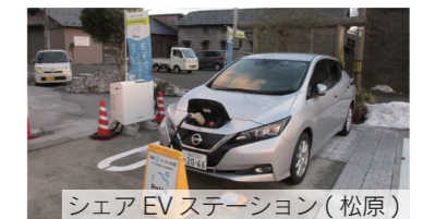
シェアEVステーション(松原)
