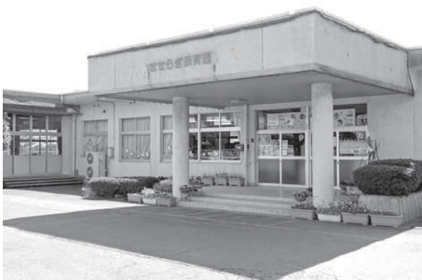
〈改修前のせせらぎ保育園〉
