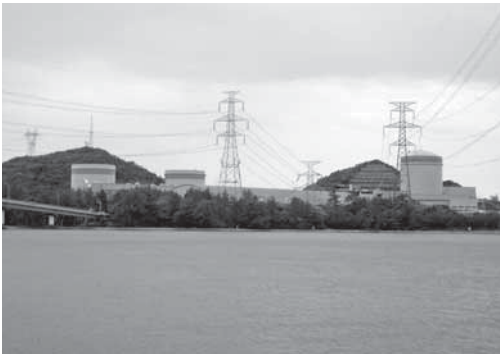
美浜発電所の全景
