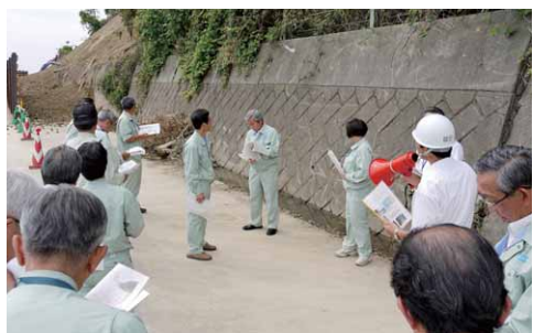
北田地係県道崩落現場
