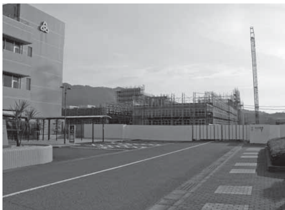
生涯学習センター「なびあす」の工事風景
