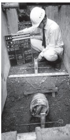
耐震パイプ埋設風景
