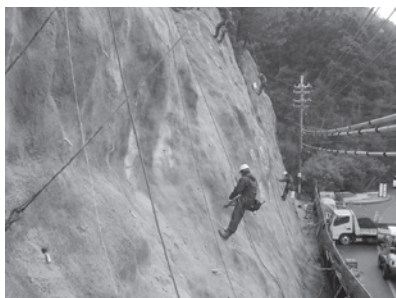
県道の保全工事の様子
