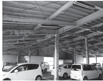
塗装改修予定の公用車車庫
