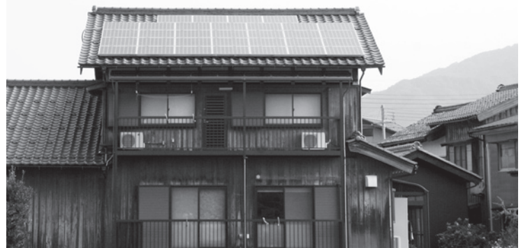
太陽光パネル
