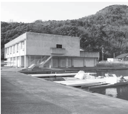
移設される県立ポートハウス
