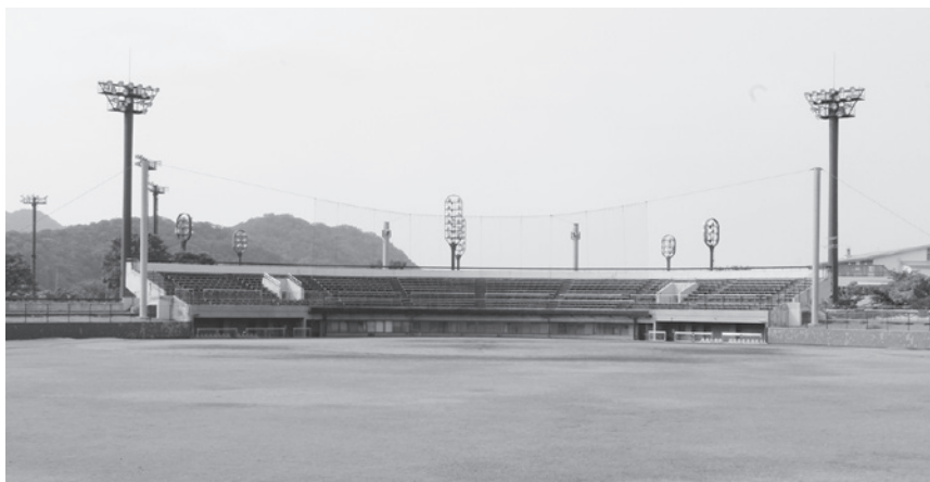
総合運動公園改修工事(福井国体に備えて)
