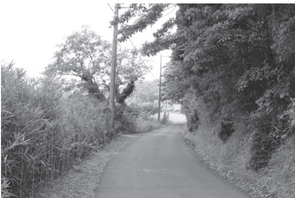
拡幅される町道日向線(写真3)
