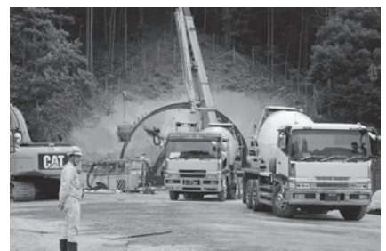
原子力災害制圧道路美浜第二トンネル工事現場
