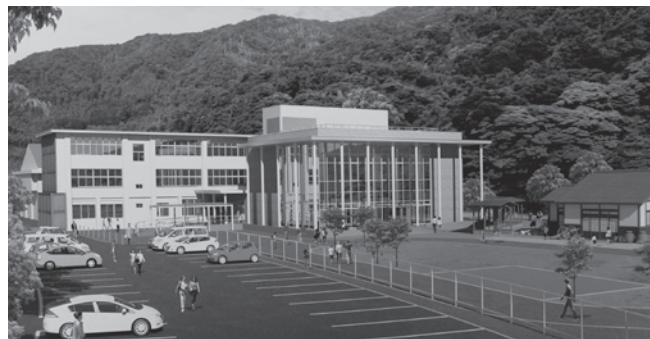
建設中の美浜町エネルギー環境教育体験施設
